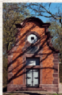
Das Wasserhaus steht mitten auf dem ehemaligen Festplatz.
